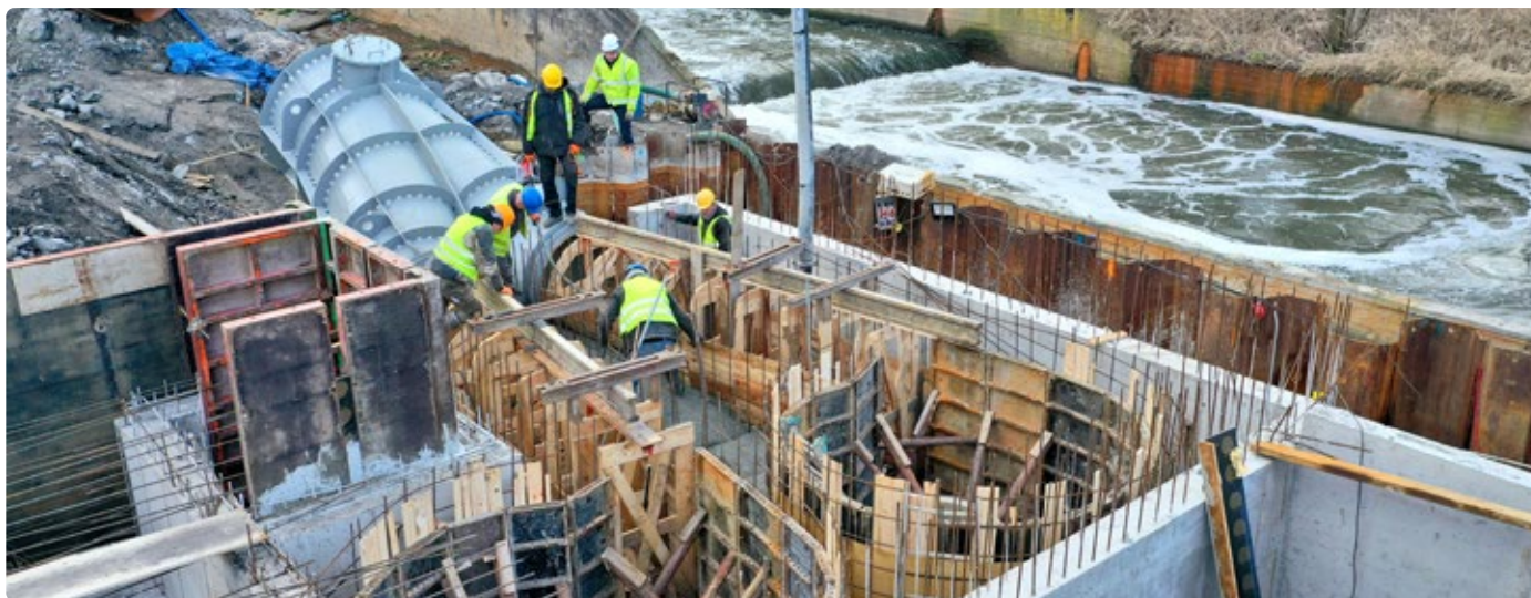
Fot. 2. Etap przygotowania do betonowania konstrukcji doprowadzenia wody do turbin
