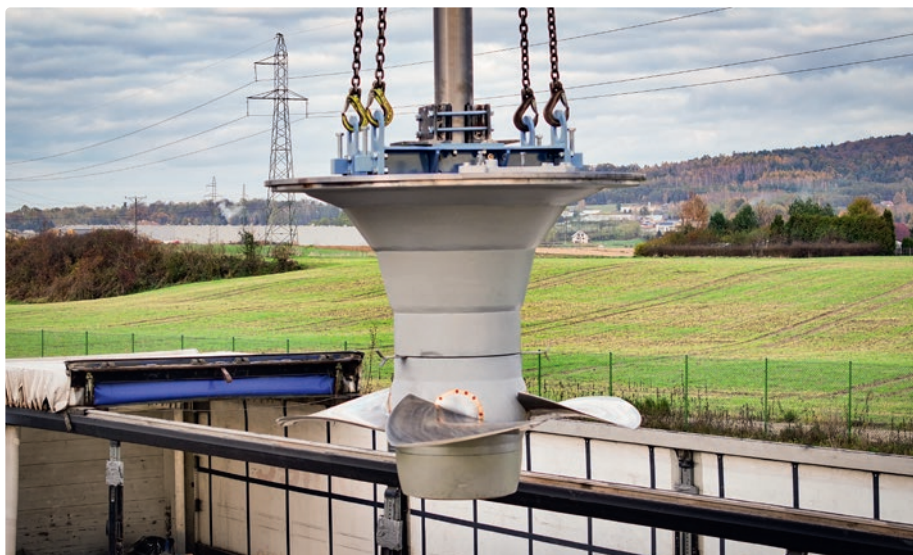
Fot. 2. Transport wirnika turbiny
