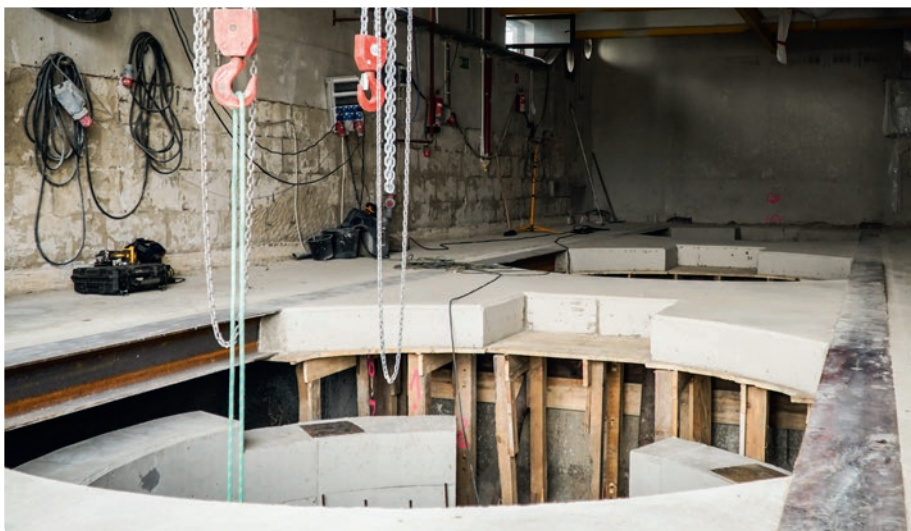
Fot. 4. Od góry: korpusy turbin w oczekiwaniu na montaż, komory turbinowe
