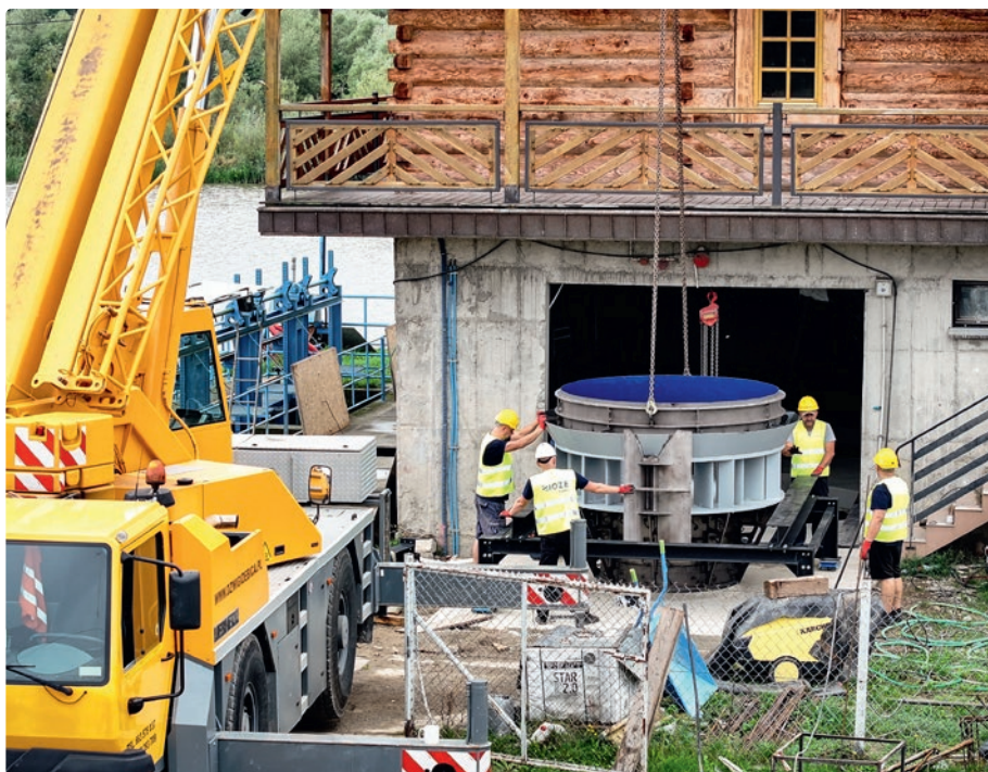
Fot. 3. Montaż komory turbiny Kaplana
