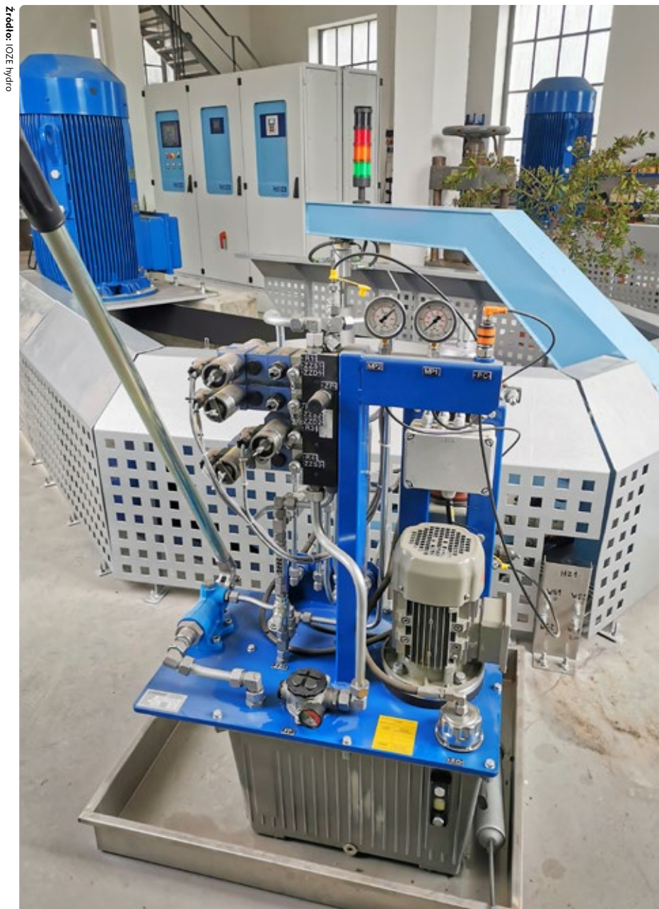
Fot. 5. Wnętrze hali maszyn po modernizacji
