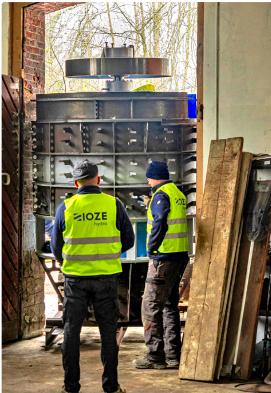
Fot. 3. Transport turbin do wnętrza młyna
