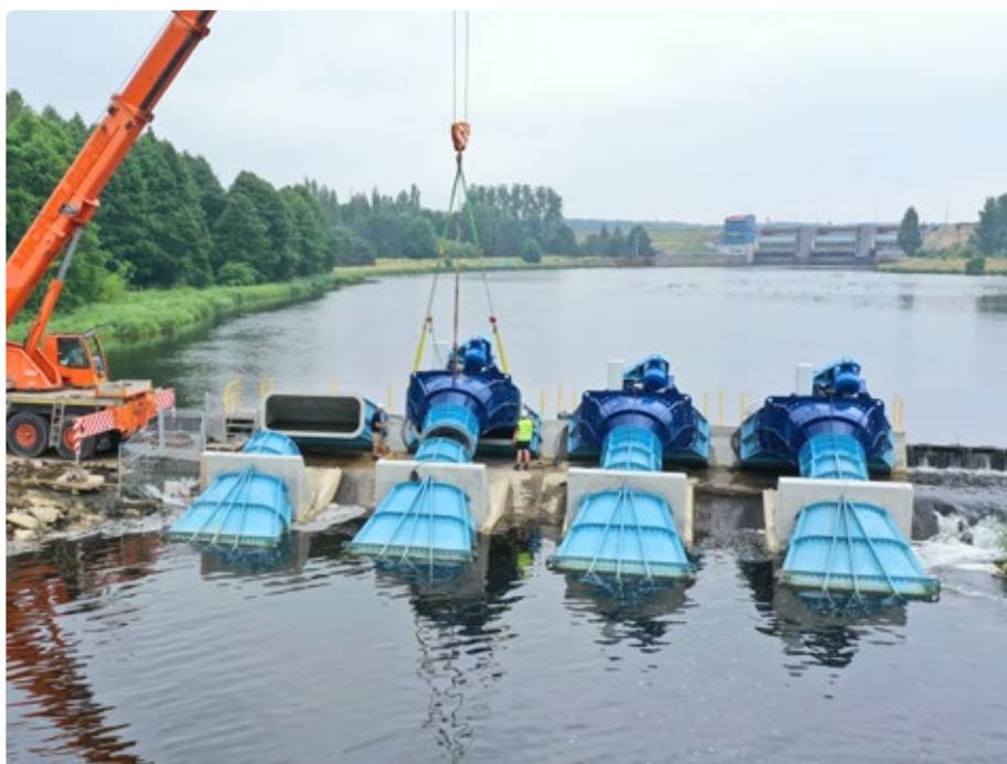
Fot. Montaż turbin lewarowych
