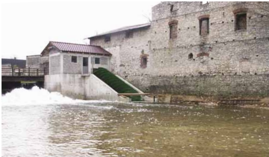
Widok na elektrownię wraz z jazem od strony wody dolnej
