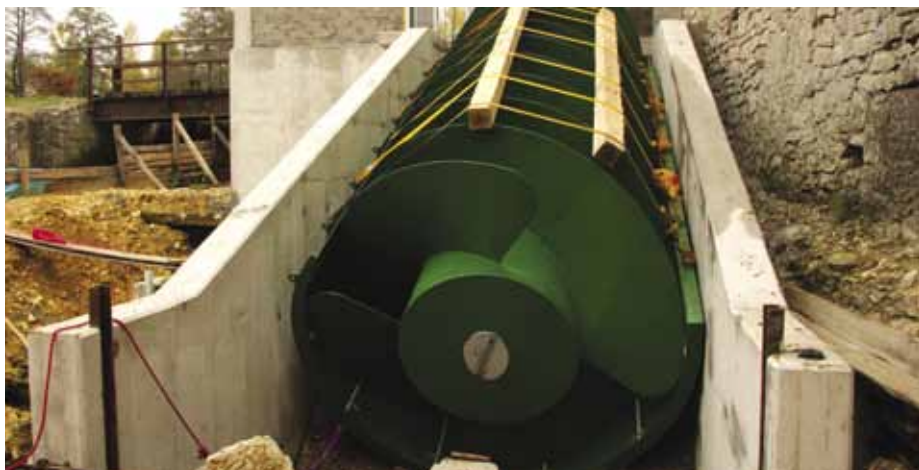
Przebieg prac instalacyjnych - śruba Archimedesesa po osadzeniu w korycie żelbetowym oraz turbina Kaplana tuż przed umieszczeniem w klatce turbinowej Fot. Michał Lis
