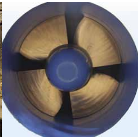
Przebieg prac instalacyjnych - śruba Archimedesesa po osadzeniu w korycie żelbetowym oraz turbina Kaplana tuż przed umieszczeniem w klatce turbinowej Fot. Michał Lis
